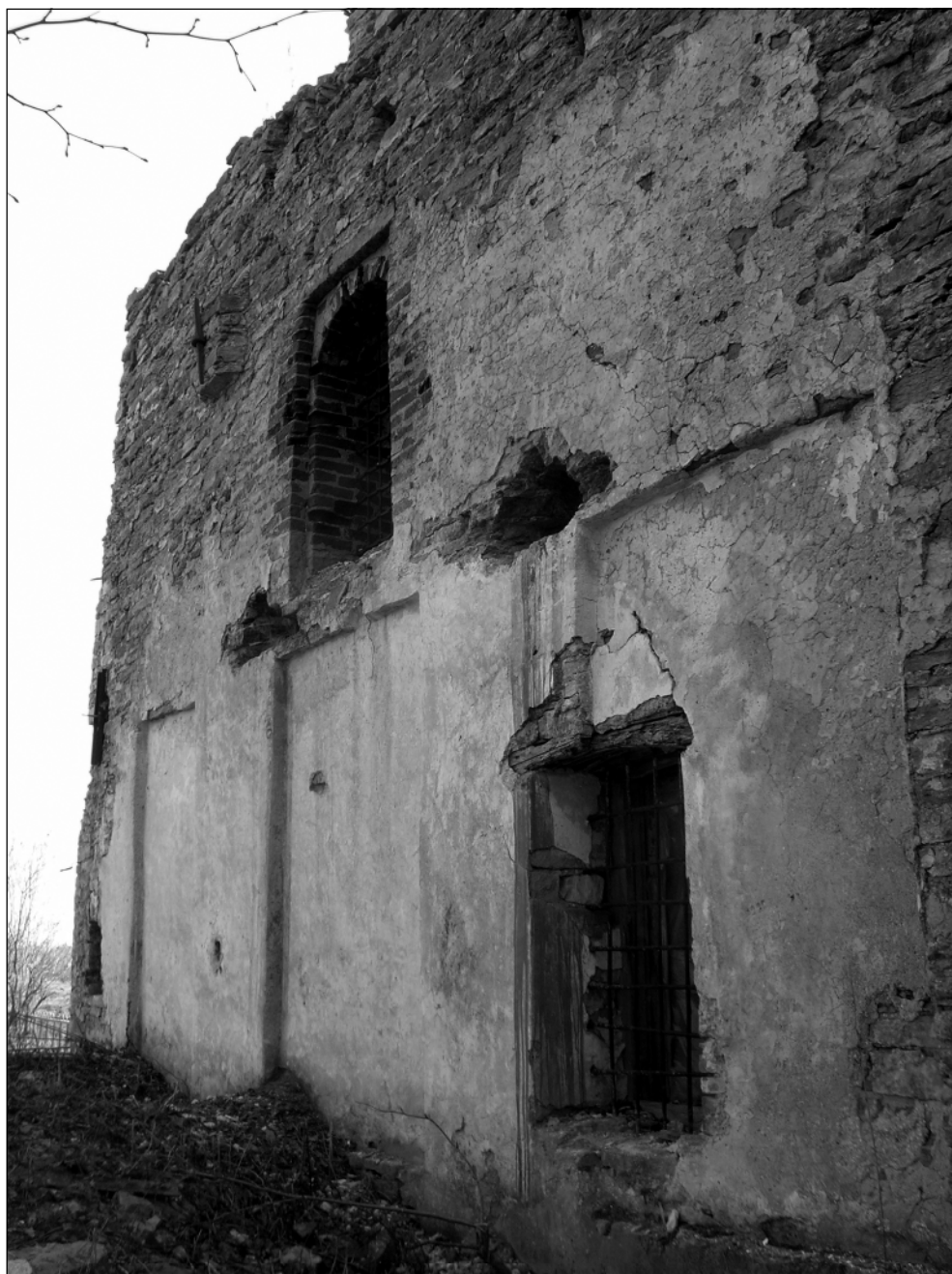
Северный фасад храма. Нижняя часть стен сохранила лопатки XVI в. Фото 2010 г.
