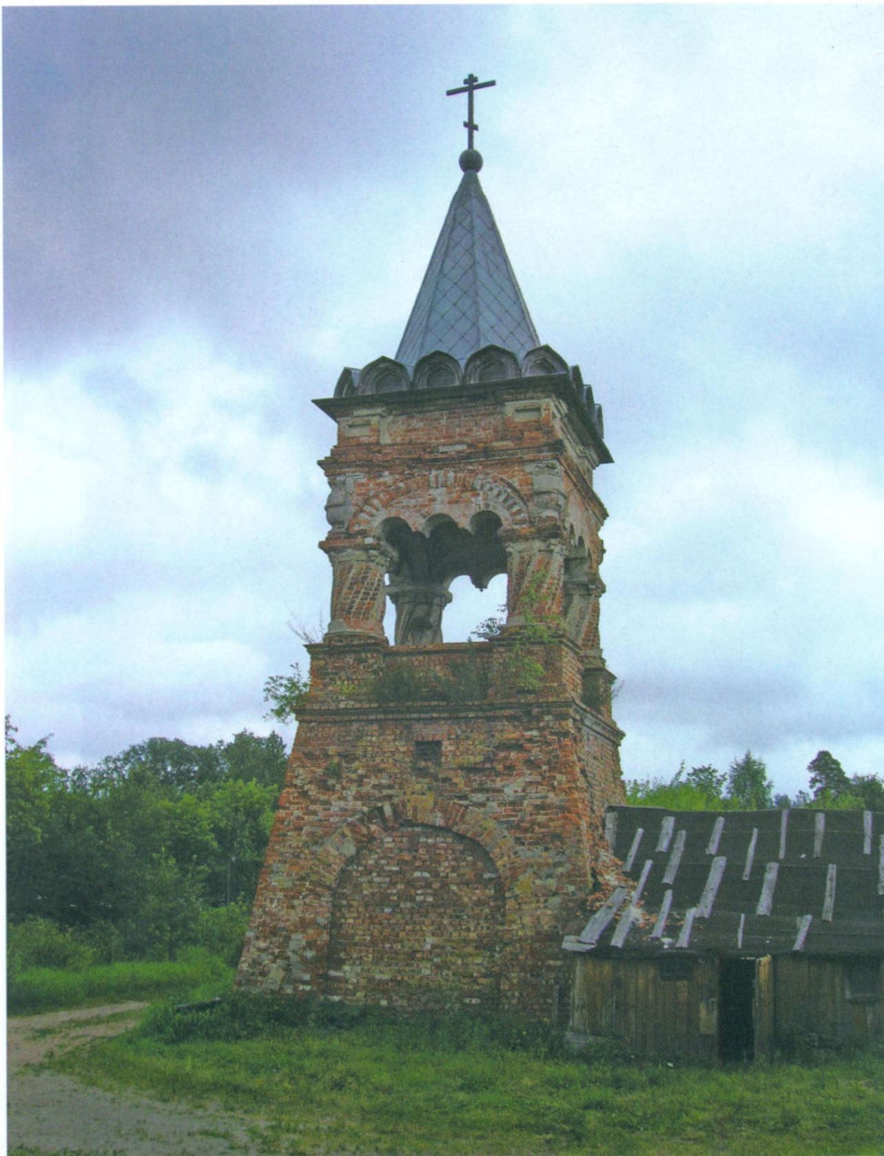
19. Колокольня на консервации до ремонта Фото автора 2 августа 2008 г.
